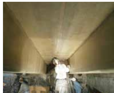
RC水槽の梁部の施工例
