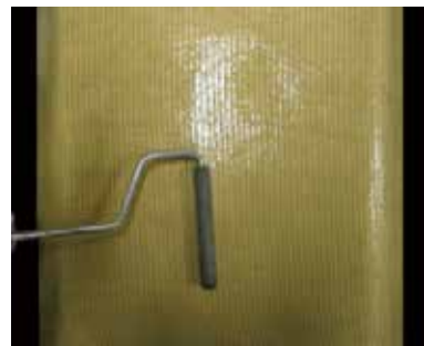
高強度アラミド繊維を貼付けた後にFRPライニングを施します
