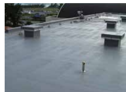
屋上防水 遮熱性
