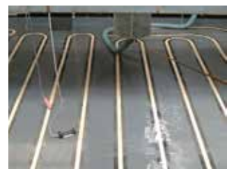
水中清掃機誘導ライン
