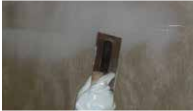
サンディング→プライマー塗布→パテ処理
