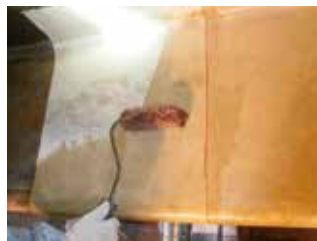
高強度アラミド繊維を貼付けた後にFRPライニングを施します
