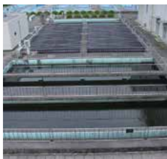
浄水場沈殿池 10年経過状況
