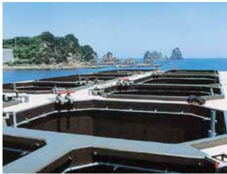
●栽培漁業センター 1981年 防水性 耐塩水性 水質安全性 鉄筋の腐食・爆裂防止
