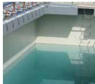
プラント排水槽
