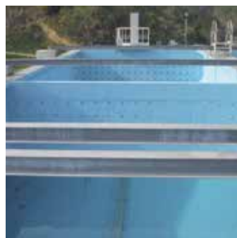
浄水場沈殿池
