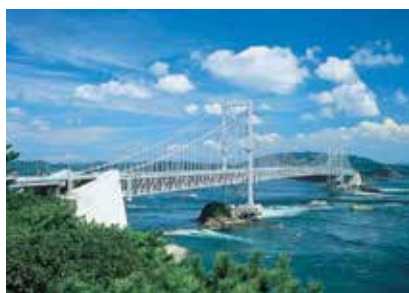
橋梁 塩害対策
