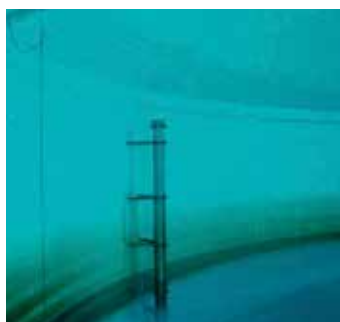
PC配水池 10年経過状況
