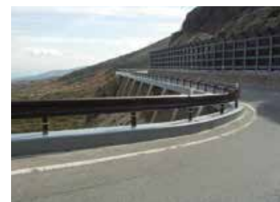
山岳地道路 劣化防止 塩害対策
