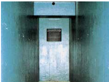
●関西国際空港排水処理槽 1993年 耐硫酸・耐硫化水素性 ひび割れ追従性
