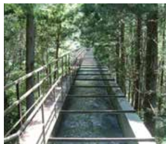
水路橋 20年経過状況
