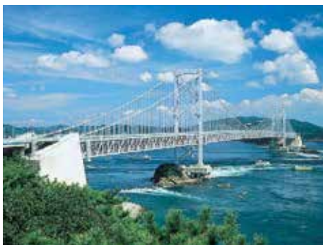
●鳴門大橋 1987年 防水性 塩害対策 耐候性
