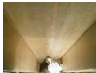
高強度アラミド繊維を貼付けた後にFRPライニングを施します
