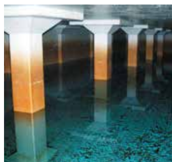
RC配水池 20年経過状況
