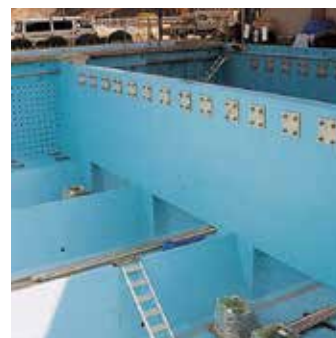
浄水場沈殿池
