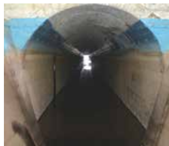
水路トンネル 20年経過状況
