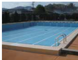
GT-2工法 プール仕様
